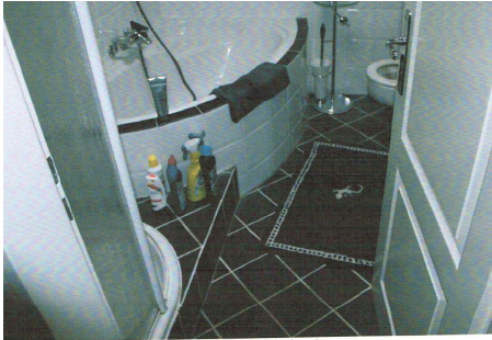
Badezimmer im Hochparterre
